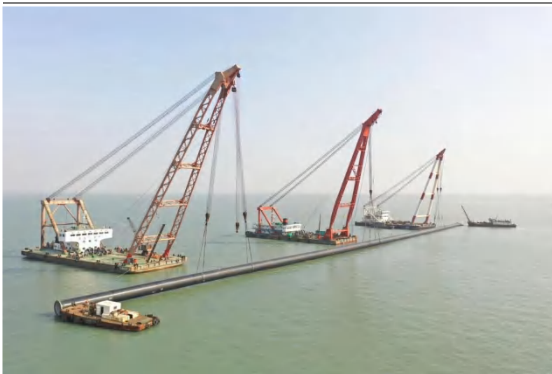
图 3.3-4 参考案例钢管水下安装现场照片
